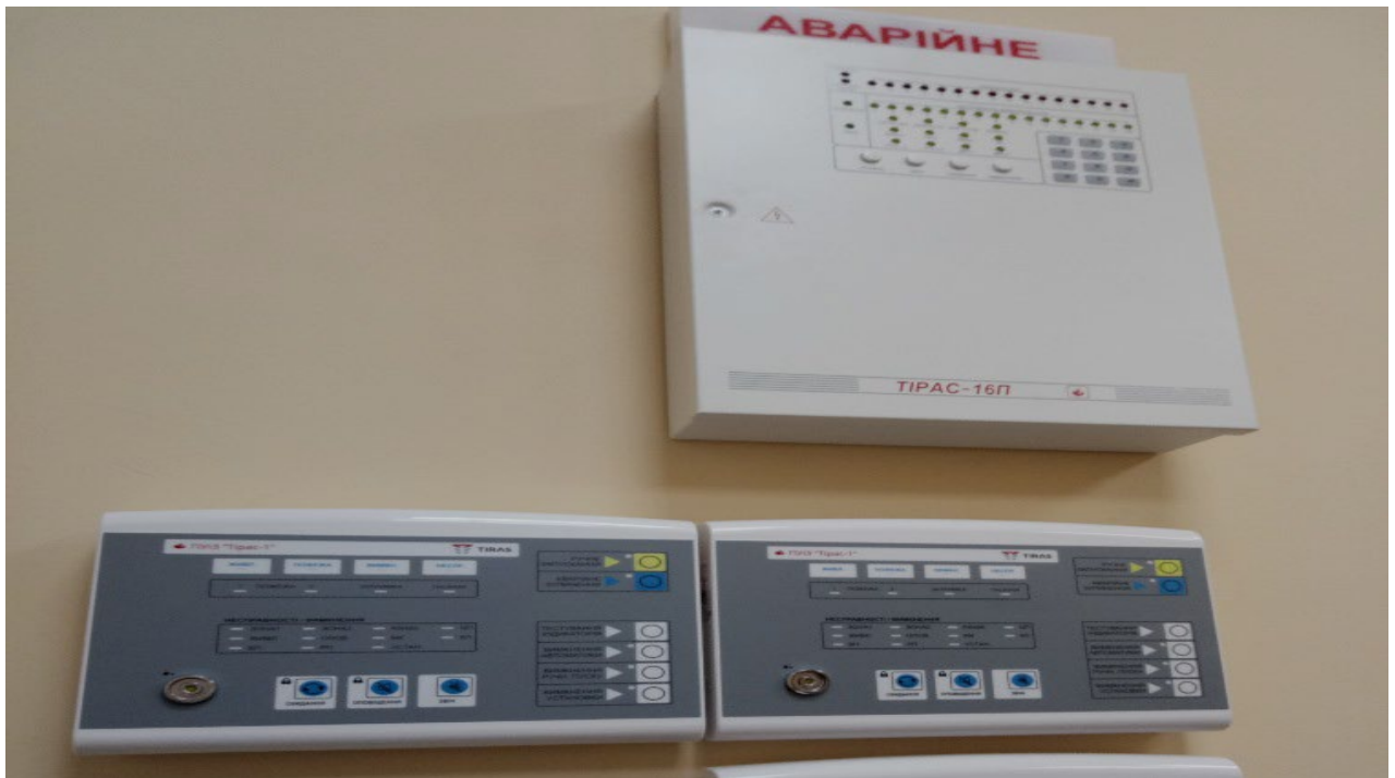
Фото 1. Система пожежної сигналізації, сповіщення про пожежу та управління евакуюванням людей у Вінницькому академічному обласному театрі ляльок, яка на момент огляду не підключена та не функціонує
