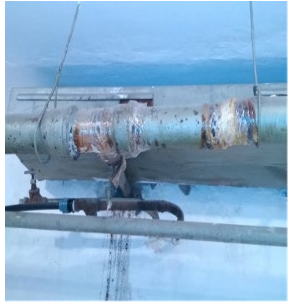
На стінах сліди плісняви. Будинкові комунікації, що проходять через приміщення ПРУ, в аварійному стані.
