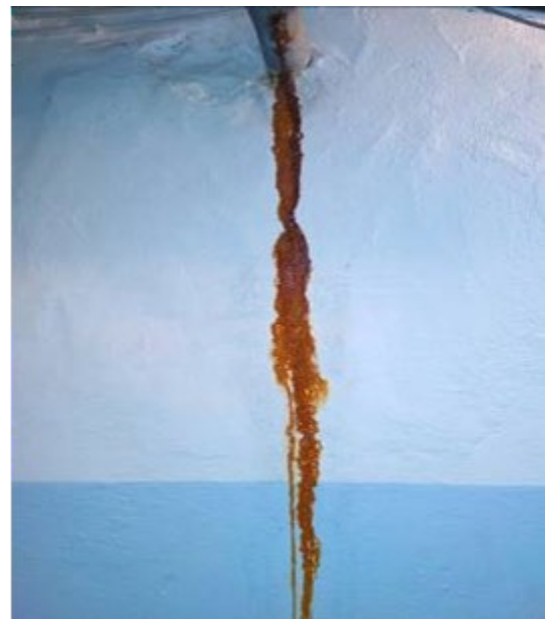
На стінах сліди плісняви. Будинкові комунікації, що проходять через приміщення ПРУ, в аварійному стані.
