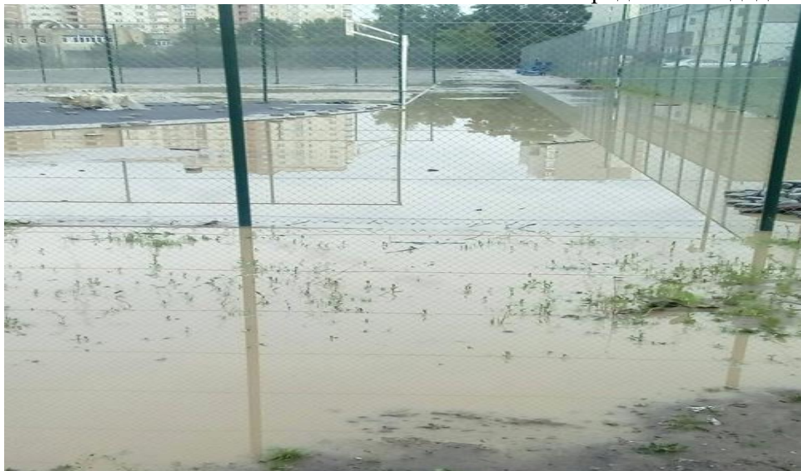
Фото. Наслідки відсутності на стадіоні СЗШ № 23 у м. Львів належної дренажної системи
