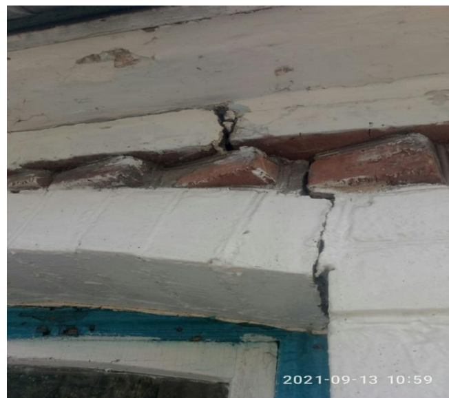
Фото 9, 10. Вертикальні суцільні тріщини по кутах цегляної кладки та вікон.
