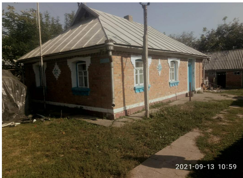
Фото 8. Зовнішній вигляд будинку
