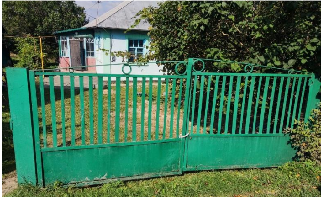
Фото 1. Зовнішній вигляд будинку
