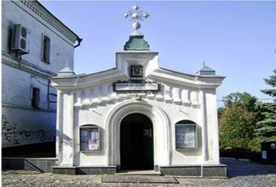
Зовнішній вигляд до перебудови
