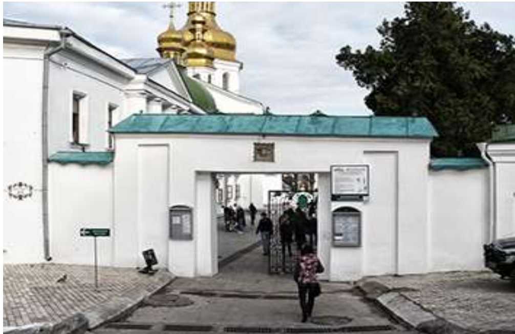
Зовнішній вигляд до перебудови
