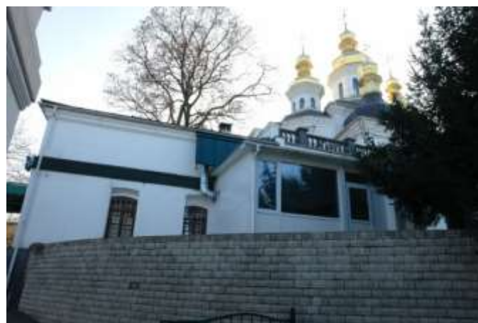
Здійснена прибудова до східного фасаду (з металопластику)
