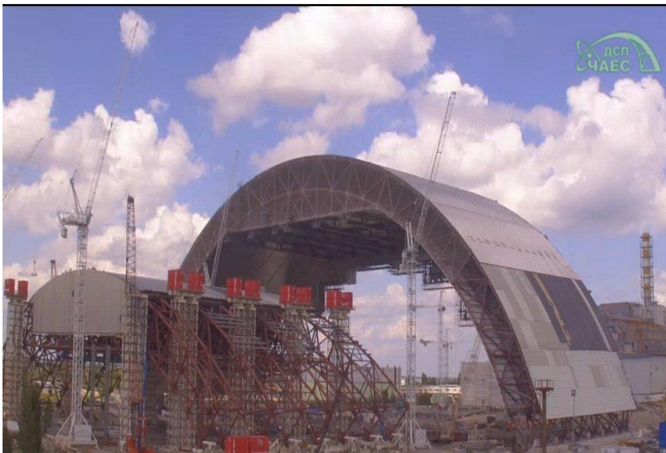
Photo. Construction Site of the Chernobyl NPP as of May 29, 2014 / Строительная площадка Чернобыльской АЭС по состоянию на 29 мая 2014 года
